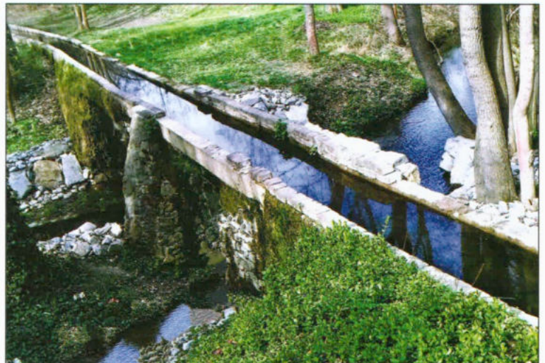
Bild 4-10 Trogbrücke aus Feld- und Werkstein als Wasserkreuz. ORH
